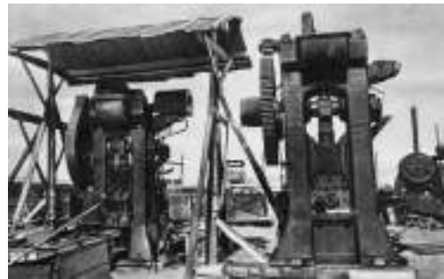
Монтаж оборудования на эвакуированном заводе. Казахстан. 1942 г.
