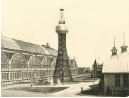
Гиперboloидная башня. Инженер В. Г. Шухов
