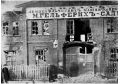
Здание склада земледельческих машин завода Гельферих-Саде после обстрела в декабре 1905 г.
