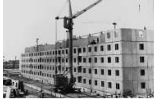
Строительство пятиэтажного жилого дома. Город Волжский
