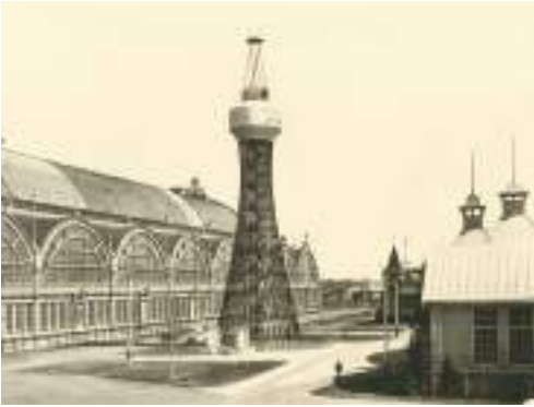
Гиперboloидная башня. Инженер В. Г. Шухов
