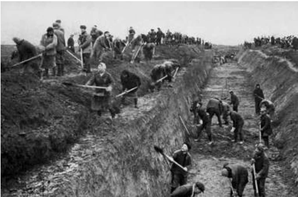
Строительство оборонительных сооружений под Москвой. Осень 1941 г.
