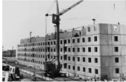
Строительство пятиэтажного жилого дома. Город Волжский
