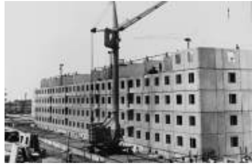
Строительство пятиэтажного жилого дома. Город Волжский
