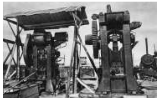
Монтаж оборудования на эвакуированном заводе. Казахстан. 1942 г.
