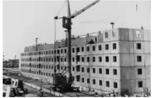
Строительство пятиэтажного жилого дома. Город Волжский
